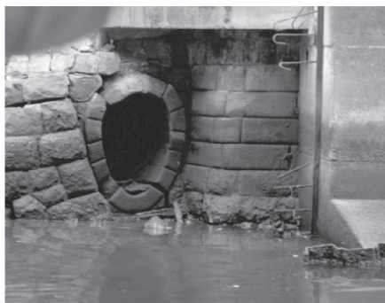
写真1 日本橋川の排水溝
